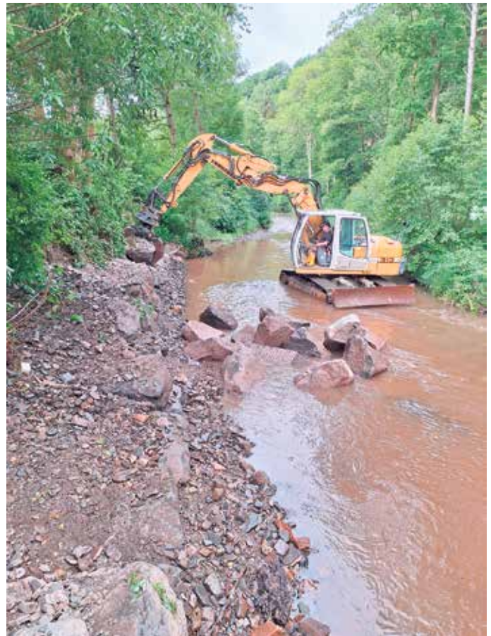
Arbeiten im Rahmen der Gewässerwiederherstellung.
