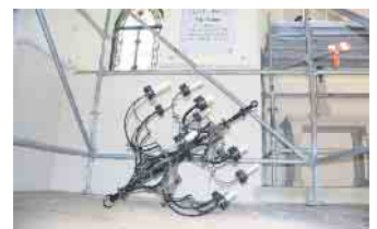
Der Innenraum der Kapelle soll im nächsten Jahr saniert werden.
