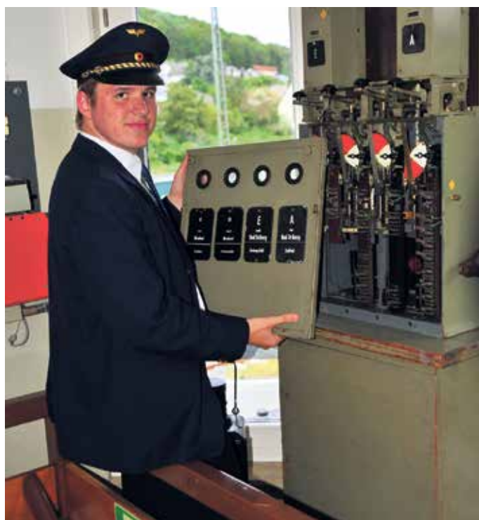
Jungwerker Marvin Meier bei der Reparatur eines sog. Blockkastens. So kann die technische Sicherung des Streckenabschnitts Bad Driburg-Herste mit originalen Teilen nachgestellt werden.
