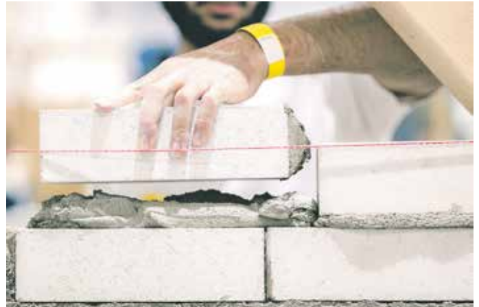
Aus Steinen werden Wohnungen: Maurer sind die Profis, die die Wohnungen im Landkreis Osnabrück bauen. Aber der Bau braucht Nachwuchs: Freie Ausbildungsplätze gibt es. Foto: IG BAU | Florian Göricke
