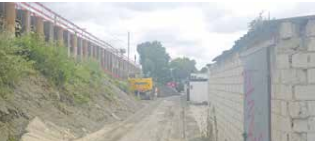
Der Bau des Bahnhofes Osnabrück-Rosenplatz schreitet werktäglich voran.
