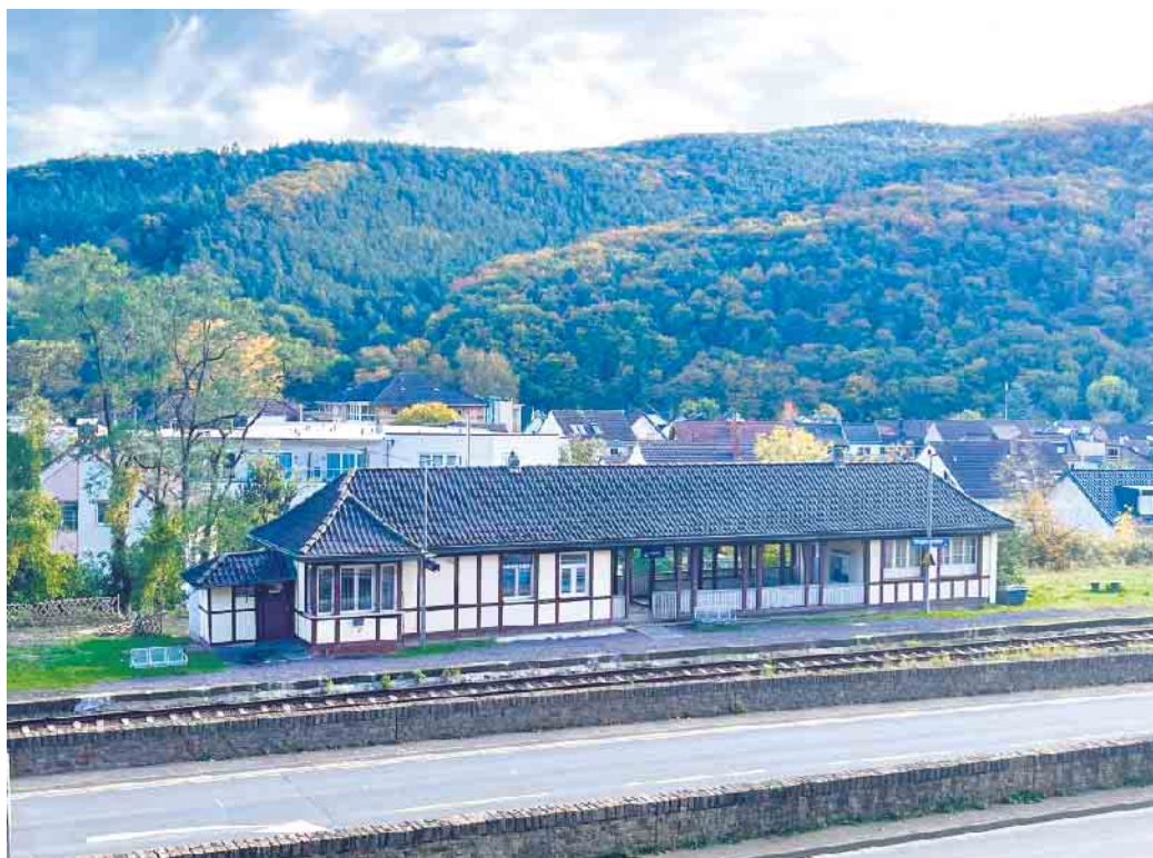
Der Bahnhof vor Abbau des Stellwerks. Foto LVR
