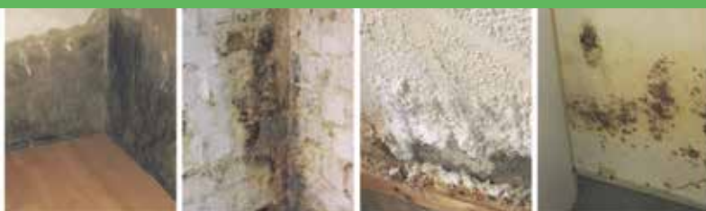
Defekte Horizontalsperre
