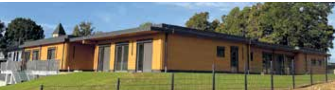
Die neue KITA Scheiderhöhe kurz vor der Inbetriebnahme
