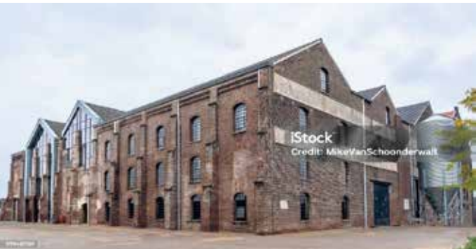
Diese alte Werkhalle kann problemlos zum Wohnhaus werden.
