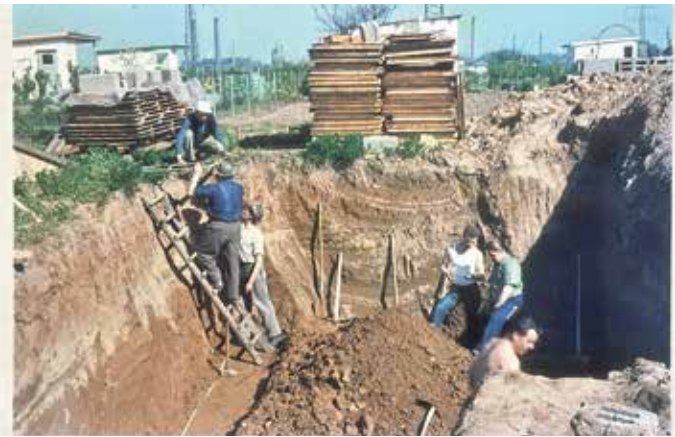
Historische Aufnahmen vom Bau des Vereinsheims
