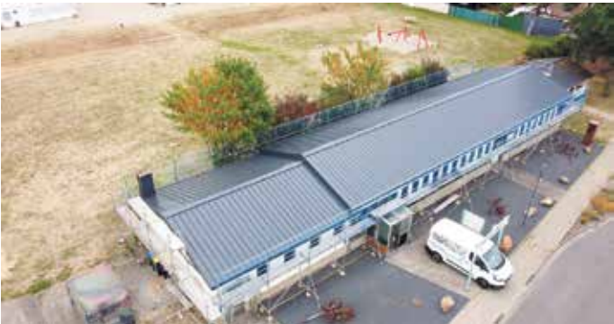
Erneuerung des Daches der Bürgerhalle Frauwüllesheim
