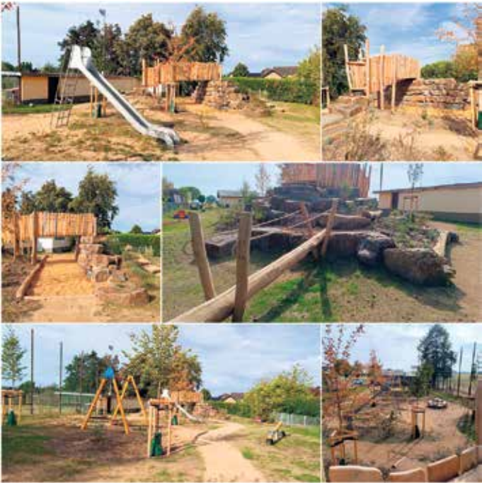
Erneuerung und Umbau Spielplatz Hochkirchen zu einem Naturspielplatz
