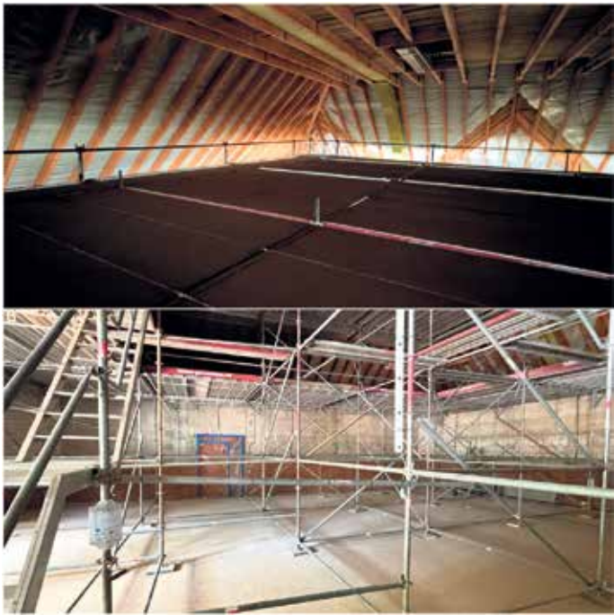
Akustische Sanierung & Brandschutzertüchtigung Neffeltalhalle
