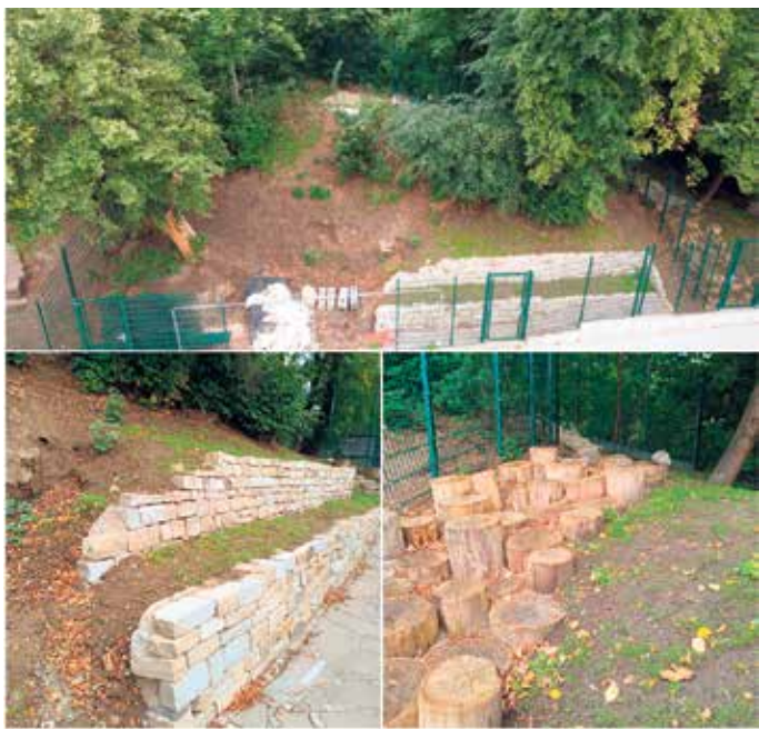
Anlegen eines Schulgartens und Bau einer Hangrutsche an der GGS Nörvenich
