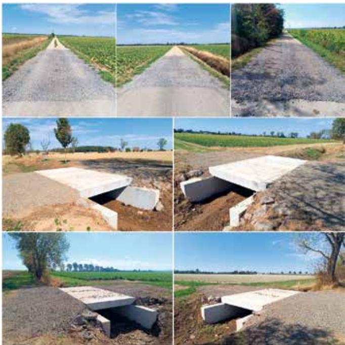
Erneuerung landwirtschaftlicher Überfahrten & Wirtschaftsweg (Hochwasserschadensbeseitigung)
