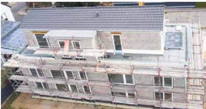
Bau von sechs kommunalen Wohnungen in der Josefstraße
