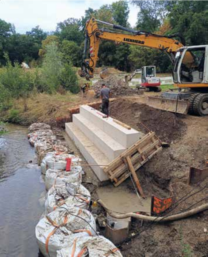
Bau einer „Treppe“ am Neffelbach
