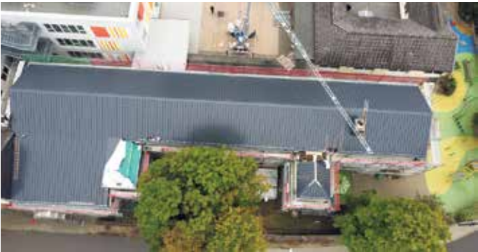
Erneuerung des Daches der Grundschule Nörvenich
