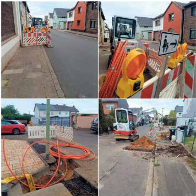
Glasfaserausbau der Ortschaft Binsfeld (danach weitere Orte)
