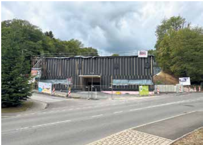
Foto: © S. Fielstette, Stadt Overath. Beim Richtfest wurde der aktuelle Baufortschritt der neuen Einfeld-Sporthalle sichtbar. Der nachhaltige Holzbau soll im zweiten Quartal 2027 fertiggestellt werden.
