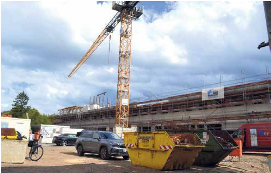
Einst eine Deponie und Ort zum Sand-Abbau: Für den Bau waren Vorarbeiten am Boden nötig. Foto: Göllnitz
