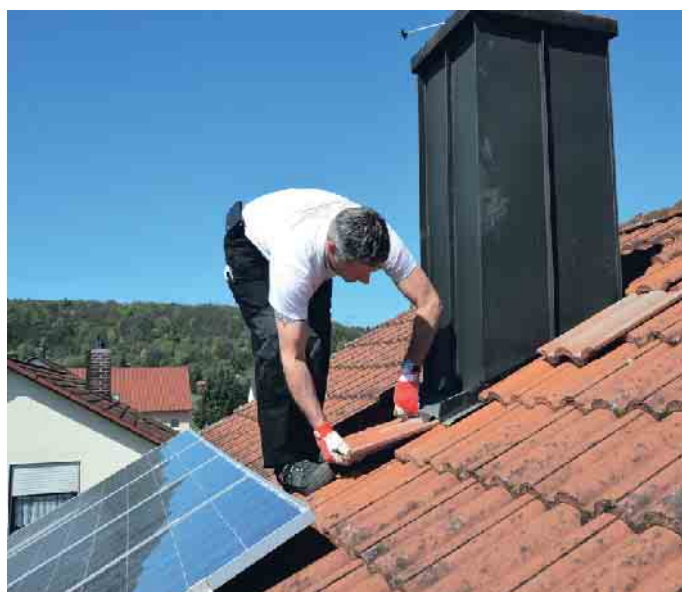
Anschlüsse an Dachdurchdringungen werden beim DachCheck begutachtet. Foto: HF Redaktion/akz—o
