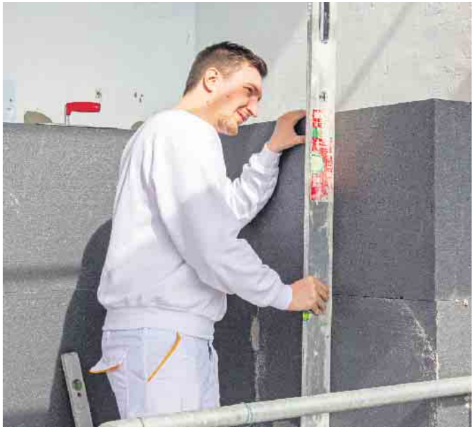
Die Dämmung der Gebäudehülle, von den Außenwänden bis zum Dach, ist einer der wichtigsten Schritte zu mehr Energieeffizienz im Altbau. Foto: djd/IVH/Felix Scholz
