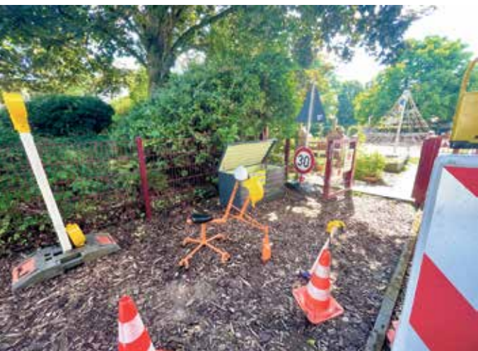
Die „Baustelle“ auf dem Kita-Gelände. Foto: Kita
