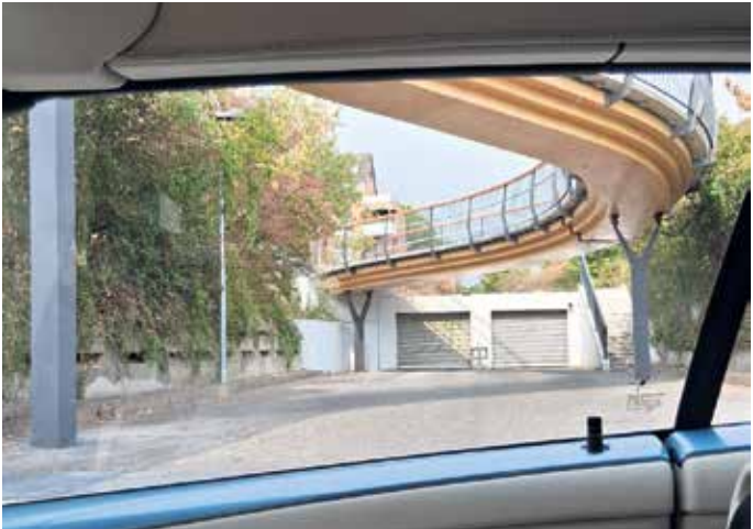
Originell und fast ein Kunstwerk: die im Herbst 2025 fertiggestellte Fußgänger- und Radfahrerbrücke über den Schwabenweg
