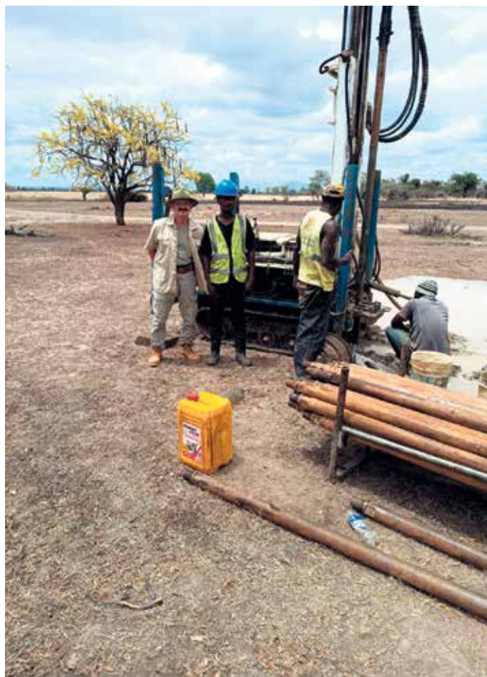
Bohrarbeiten in Makutere / tansanische Savanne bis ca. 80 Meter Tiefe
